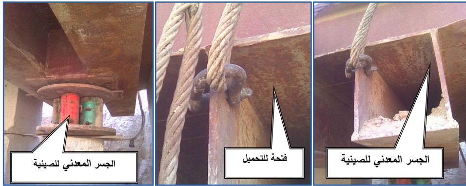
الشكل (9-4): تفاصيل الصينية المعدنية
