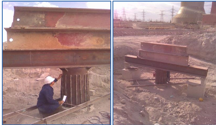
الشكل (4-94) تصميم وتلحيم الجوائز البسيطة الشكلة للجائز المعدني
