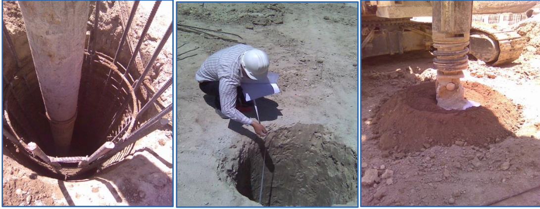
الشكل (4-96) متابعة أعمال الحفر و التأكيس و الصب للأوتاد البيتونية و موقع المحطة
