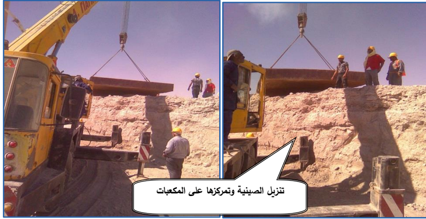
الشكل (4-15): تنزيل الصينية على المكعبات
