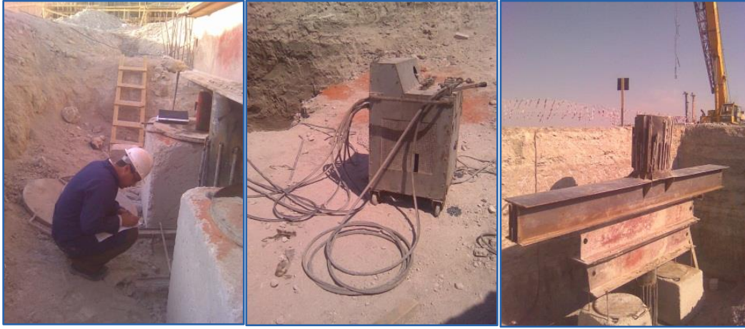
الشكل (4-103) تركيب الجكات وتوصيل الطرنبة لتجربة الشد
