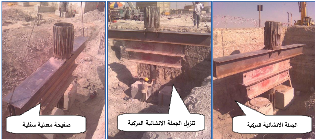
الشكل (98-4) طريقة تركيب الجائر المعدني باخل قضبان التسليح للوتد المختبر على الشد
