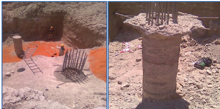
الشكل (4-101) تأكيس الحفرة و فرش رمل المزار
