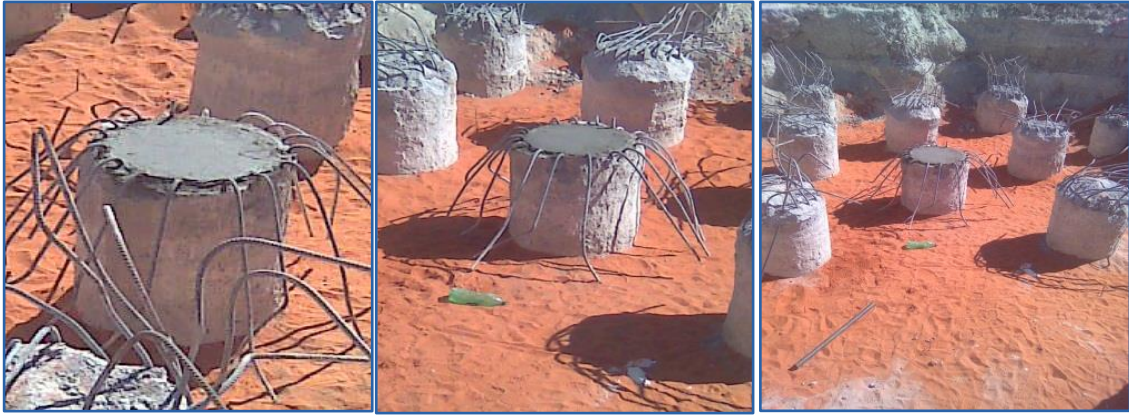
الشكل (4-37): صب رأس الوتد
