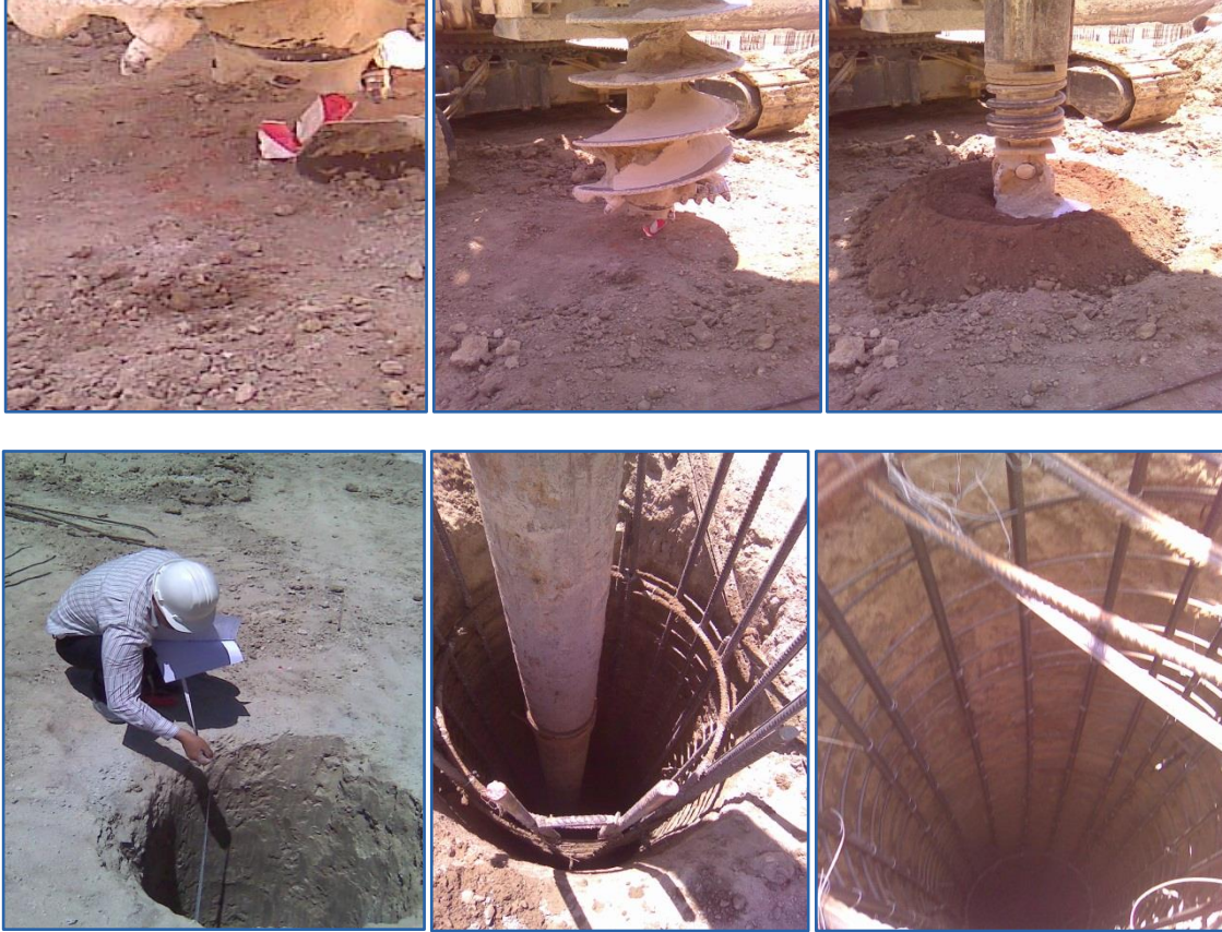
الشكل (1-4): مراحل تنفيذ الأوتاد
