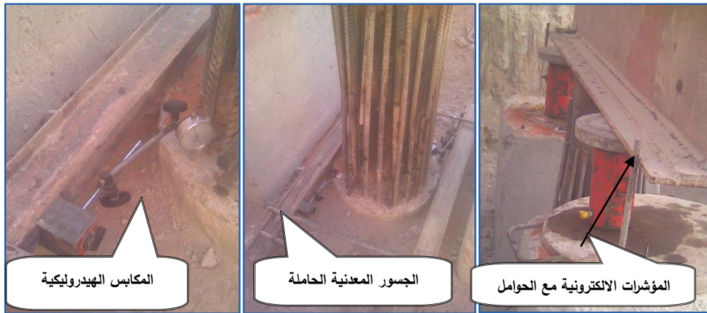
الشكل (4-100) تركيب الكريكيوات و تجهيز المؤشرات
