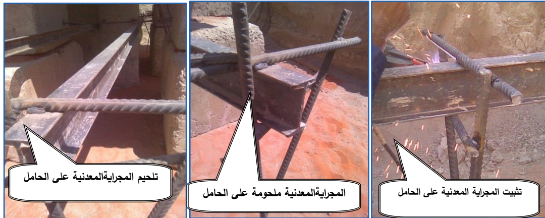
الشكل (4-12): تثبيت المجاري المعدنية على الحوامل
