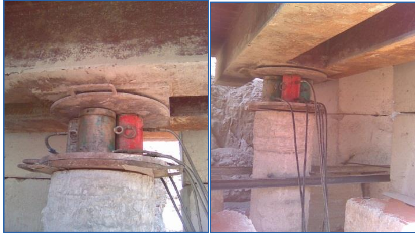
الشكل (4-18): تركيب الجكات الهيدروليكية
