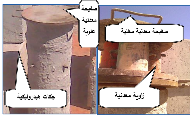
الشكل (4-6): تركيب الصفائح المعدنية و الجكات الهيدروليكية على رأس الوتد
