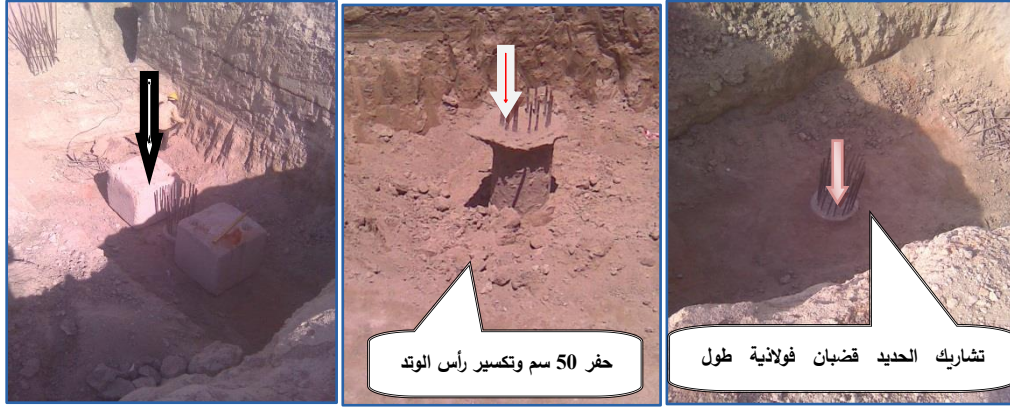
الشكل (97-4) تكسير رأس الوتد وجلخ رأسه وتنظيف الحفرية للتجيز لتجربة الشد
