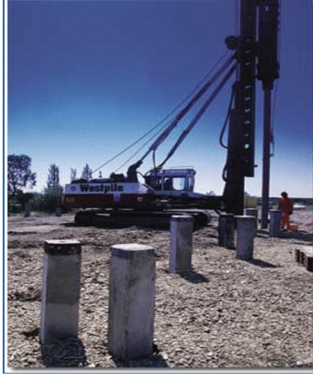
الشكل (8-1): مقاطع مربعة لأوتاد مسبقة الصب مع تسليح عادي
