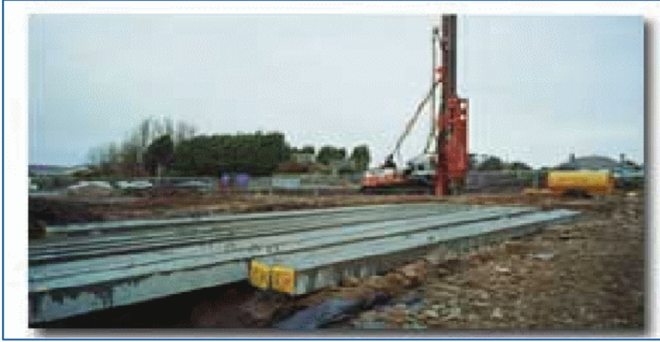
الشكل (5-1) أوتاد مدفوعة مسبقة الصنع من البيتون المسلح
