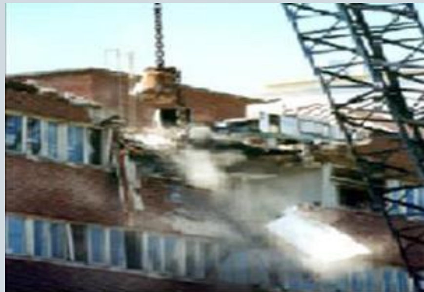
الهدم الميكانيكي باستخدام الكرة الساقطة
