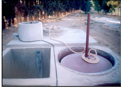
الصورة (1) توضح وحدة الهاضم طراز صيني
