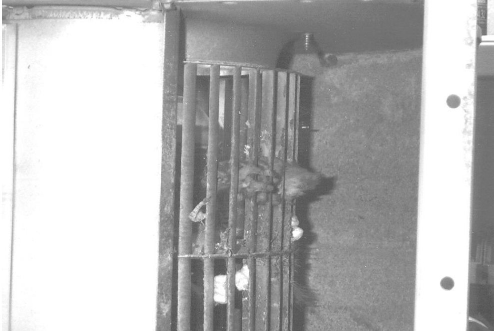
Foreign object in fan (Courtesy of ABB Inc.) أجسام غريبة في المروحة
