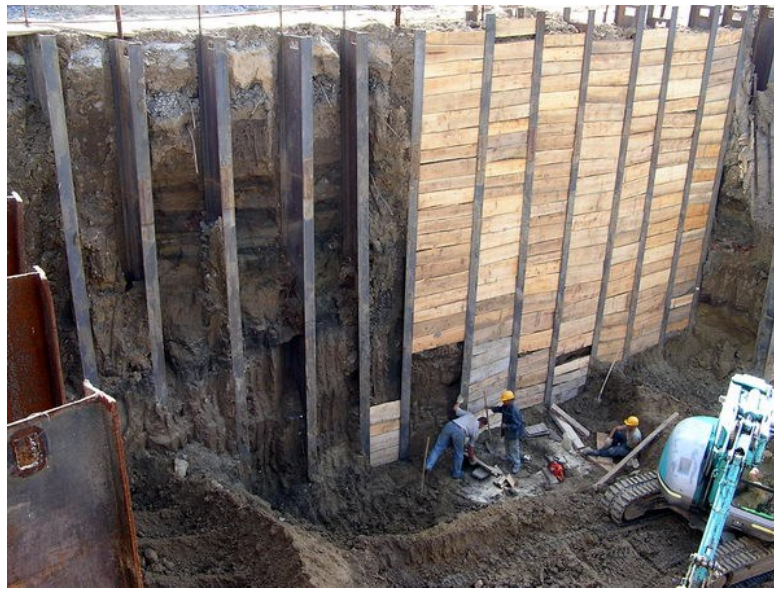
الشكل (3-6): هياكل التدعيم الظفرية الجانزية
