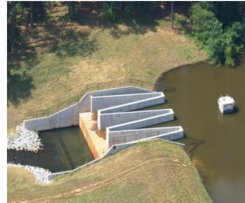
-a- مفيض حرجاني، -b- مفيض حرجاني على شكل متاهة، -c- مفيض سيفوني.
