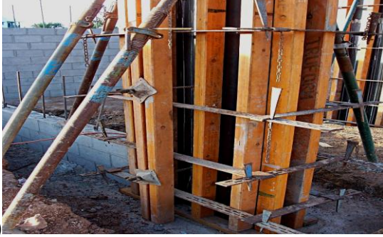
الشكل (7) تشييد قوالب خشبية لصب البيتون المسلح
