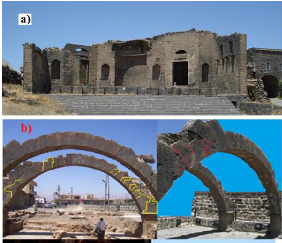
الشكل (9): (a) بناء يستمر بالعمل لآلاف السنين بمخمدات زلزالية. (b) أقواس بأحجار بازلتية متداخلة كمخمدات في قرية صما البردان في السويداء.
