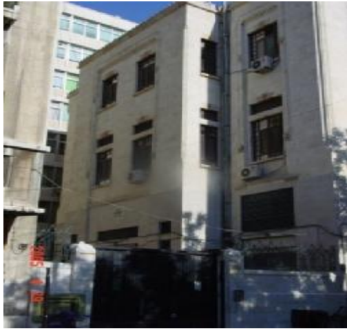
الصورة (3-2-2-13)، الواجهة الخلفية الشمالية .
