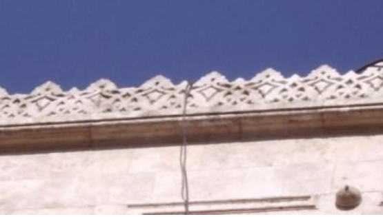
الصورة (3-2-3-11) الكورنيش أعلى البناء. (33)
