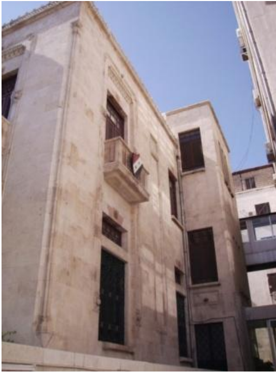
الصورة (3-2-2-5) الواجهة الشرقية الجانبية . (30)
