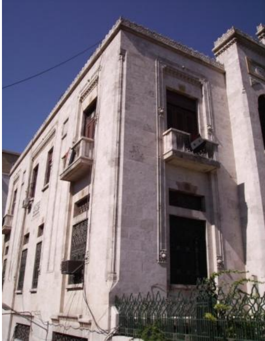
الصورة (3-2-2-8)، الواجهة الجانبية الغربية.
