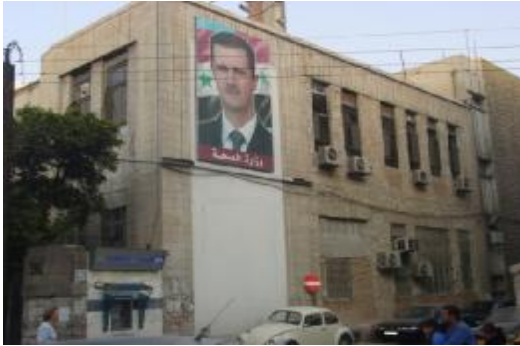
الصورة (3-1-2-4) بناء وزارة الصحة. (34)
