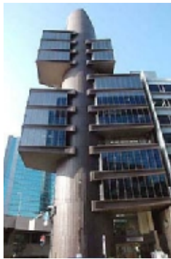
الشكل (5) توضيح الدور الإنشائي الخدمي لبطارية الخدمة [3].
