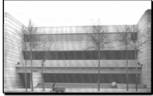
الصورة (29)، الرصيف الخارجي للمبنى والمدخل. 38
