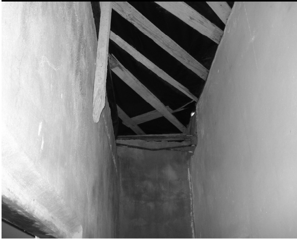
الشكل (11): صورة لسقف موزع من الخشب
